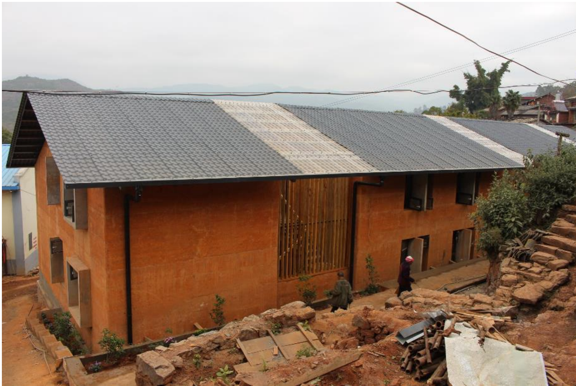
主體建築完成 - 西南角
