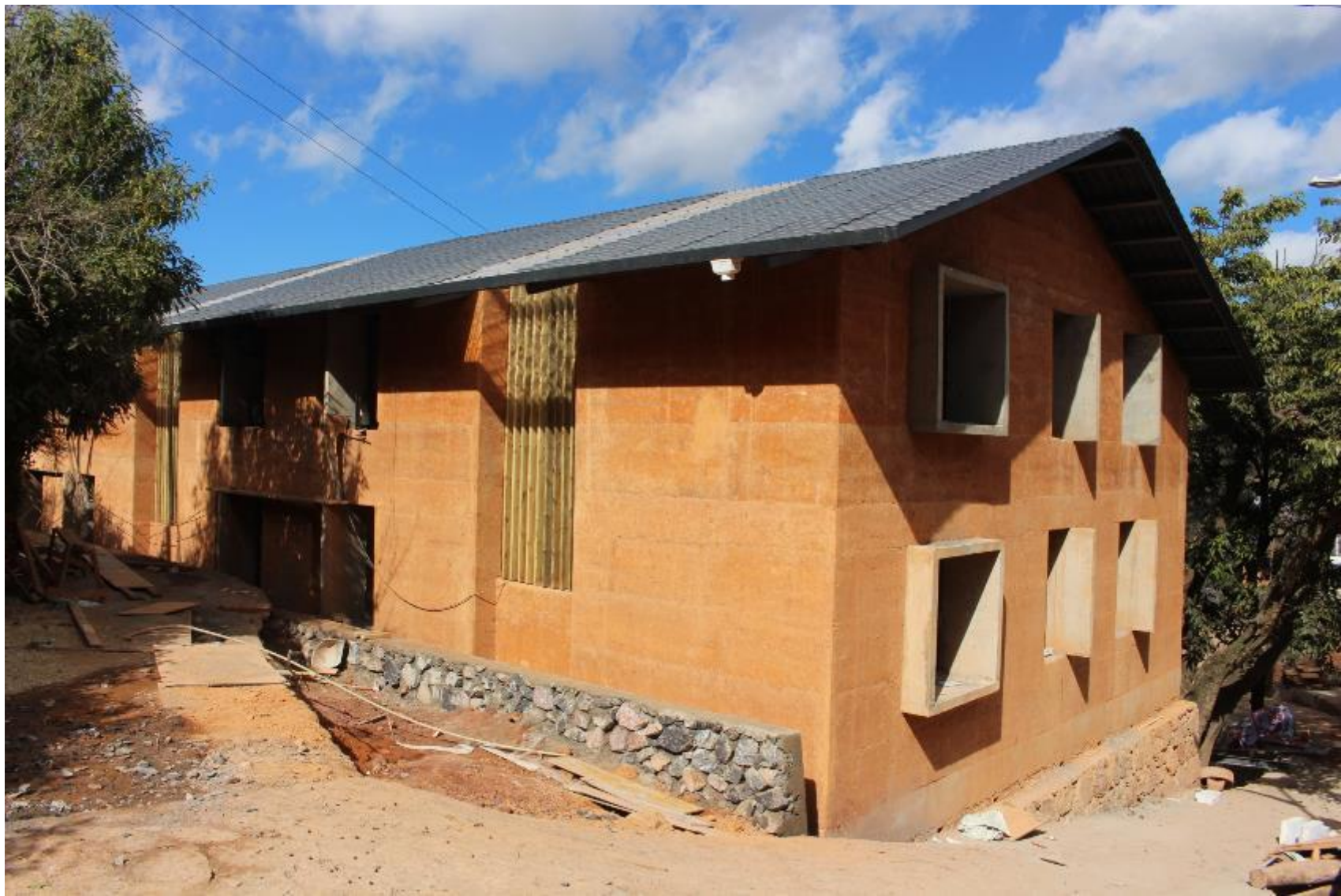
主體建築完成 - 東南立面
