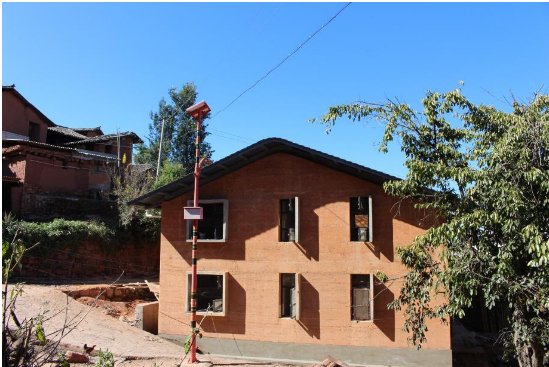
主體建築完成 - 東南立面
